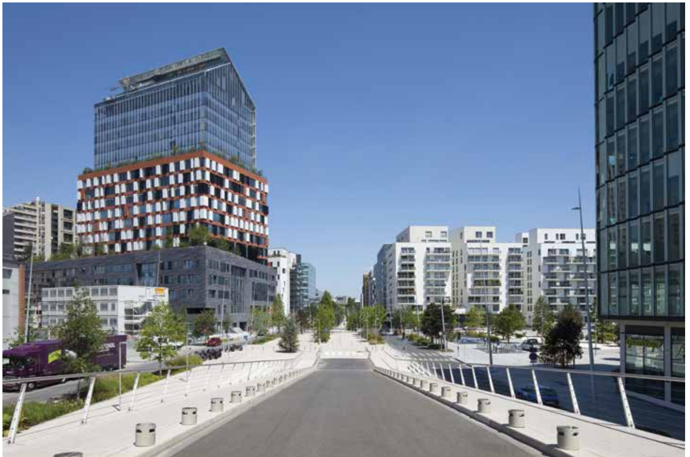
Une forte exigence pour des bâtiments économes en énergie 1. Immeuble de logements / 2. Tour Horizons (bureaux)
