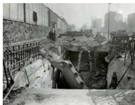
■ La station de métro du Pont-de-Sèvres après le bombardement du 4 avril 1943.
