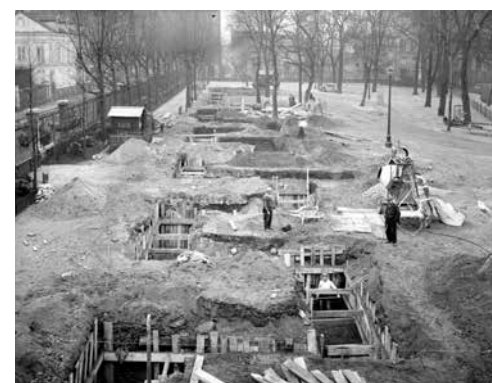
■ Construction de l'abri anti-aérien sous le square de l'Ancienne-Mairie (actuel square Léon-Blum).
