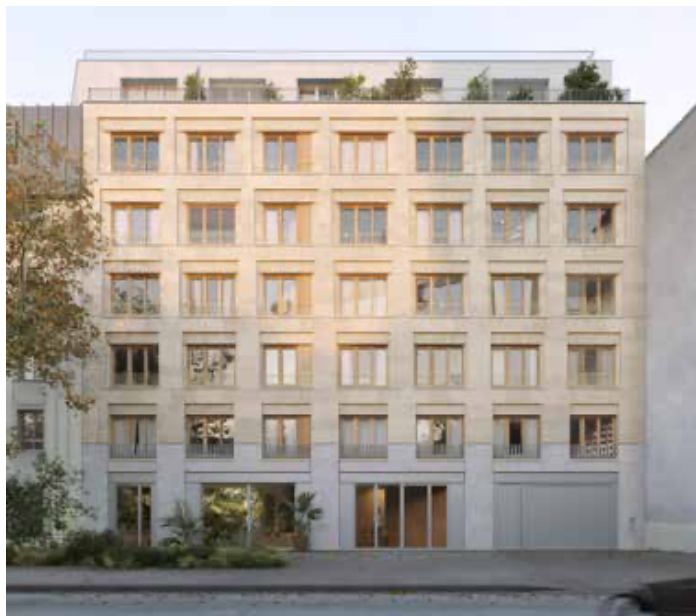
■ 14, rue des Quatre-Cheminées.
