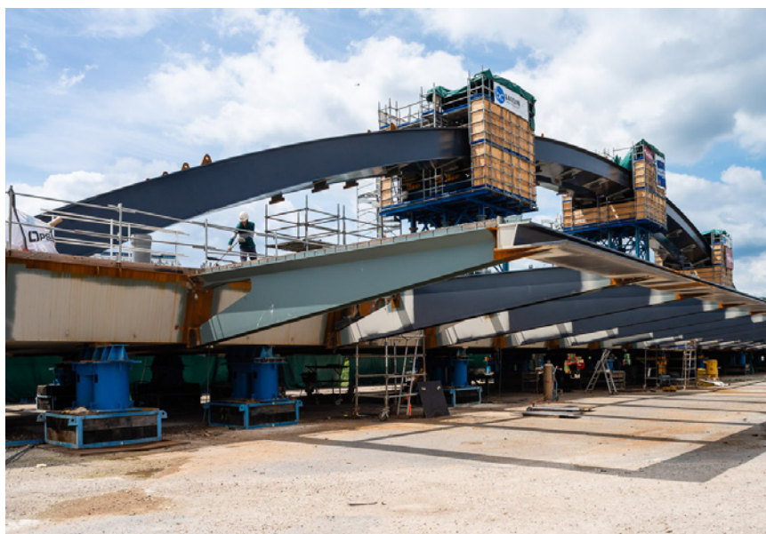
Chantier du Pont Seibert.
